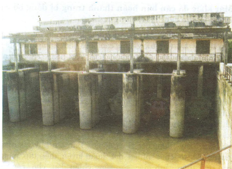
Trạm bơm Nhu Trác được xây dựng từ năm 1969.
